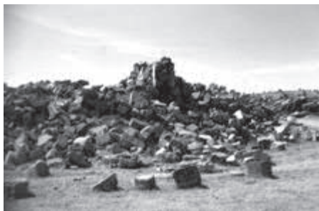
[036] Estado en que quedó la Iglesia de Argusino tras su demolición por parte de Iberduero (1967).
