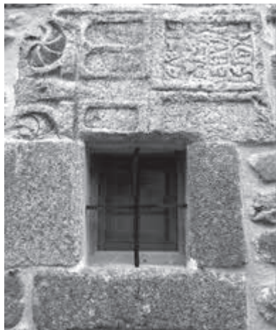
Aspecto actual del ventanuco de la antigua escuela de Escudro, coronado por una estela romana reaprovechada en el momento de la construcción del edificio.
