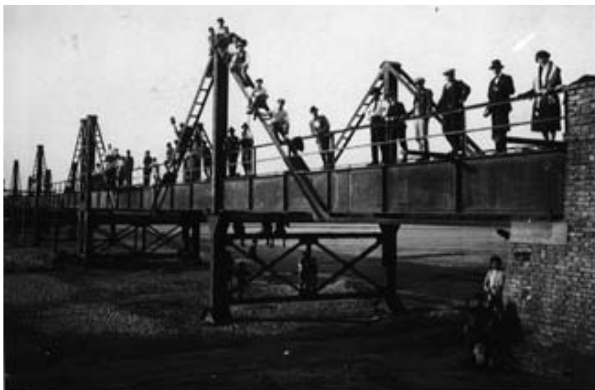
Otra vista del puente de Villa del Rosario Cordoba- Argentina, en una etapa de su construcción. Se aprecia la presencia en la misma de Emiliano Moisés(indicado)
