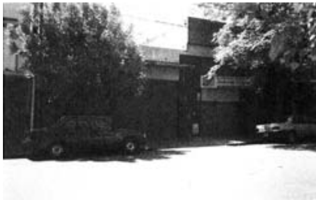
Frente al edificio actual de la fábrica de cortinas metálicas Jaime Viguri, S.C.A.
